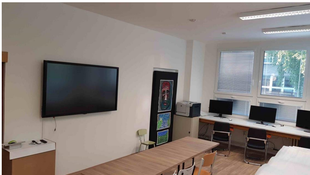
Počítačové a grafické studio po rekonstrukci vybavené velkoplošným displejem
